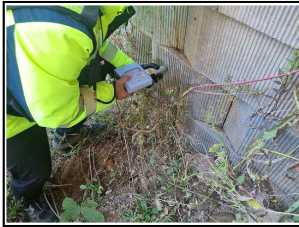
【그림 1.3.6】 슈미트해머를 이용한 반발경도시험 전경
